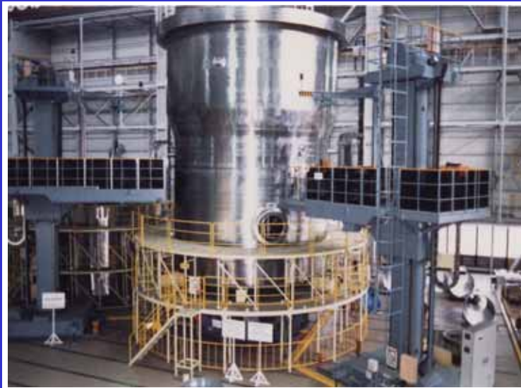
写真4-12 上部胴・中間胴溶接
