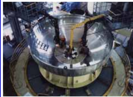
写真4-10 下部サポート溶接
