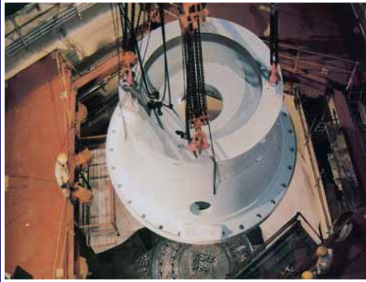
写真2-2 下部支持構造物の吊り込み状況
