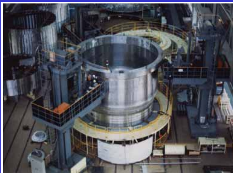
写真4-7 上部フランジ溶接
