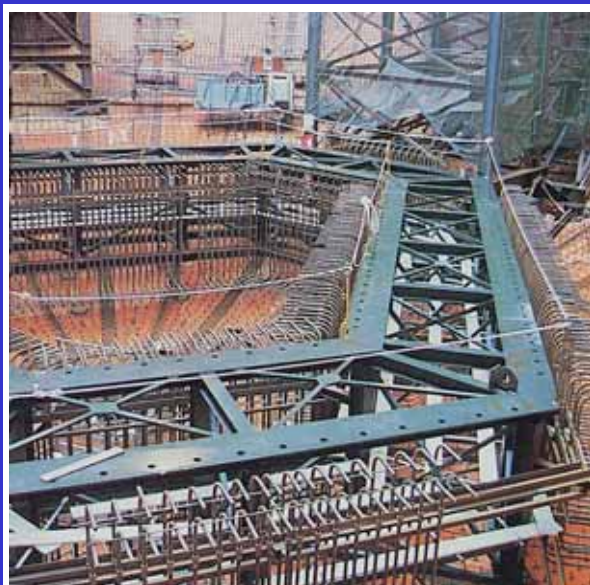
写真1-5 基礎架台の設定
