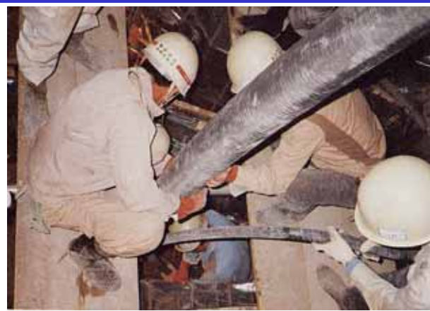
写真1-12 生体しゃへい壁の打設状況3
