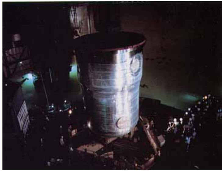
写真3-4 ガードベッセル吊り込み(6月18日)
