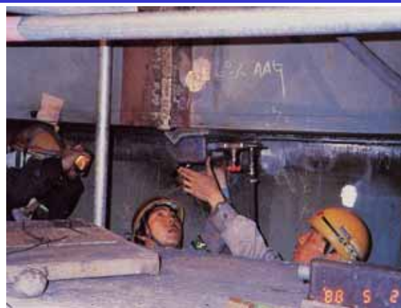
写真1-10 真空引き試験
