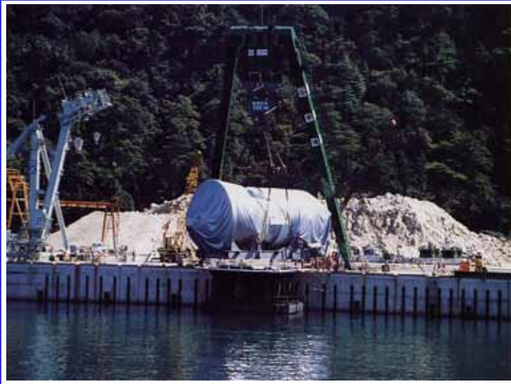
写真4-15 吊り上げられた原子炉容器
