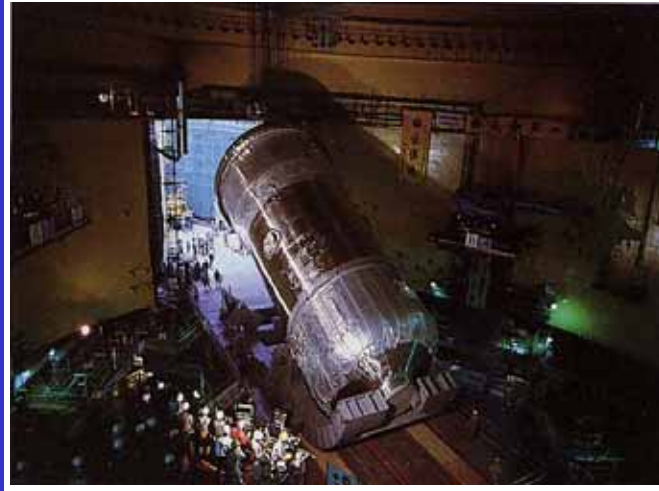
写真4-17 原子炉容器据付開始(9:00)
