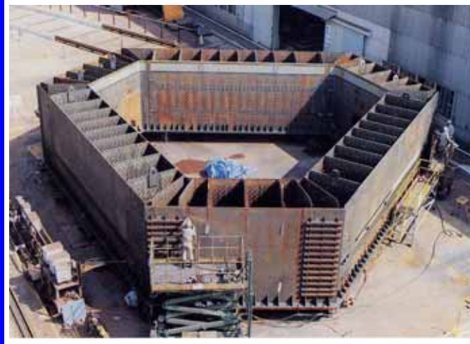
写真1-2 工場仮組立(1段ブロック)
