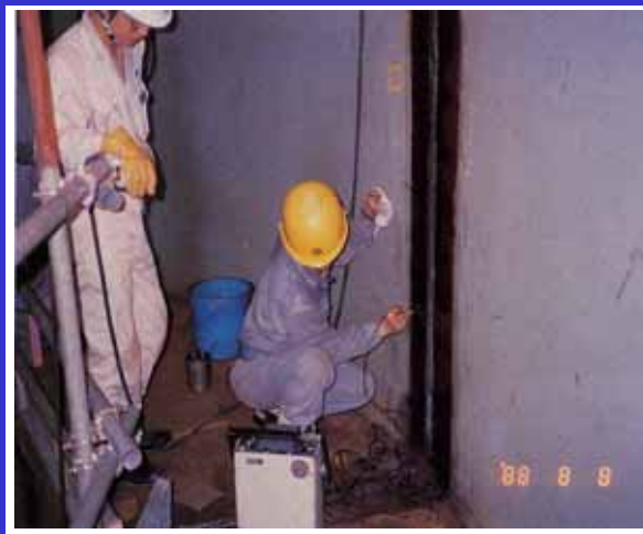
写真1-9 超音波探傷検査
